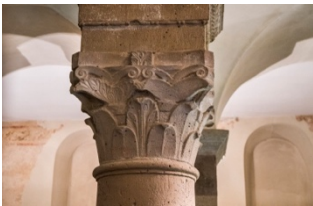
Kapitelle in der Erdgeschosshalle im Westwerk Foto: Kalle Noltenhans
